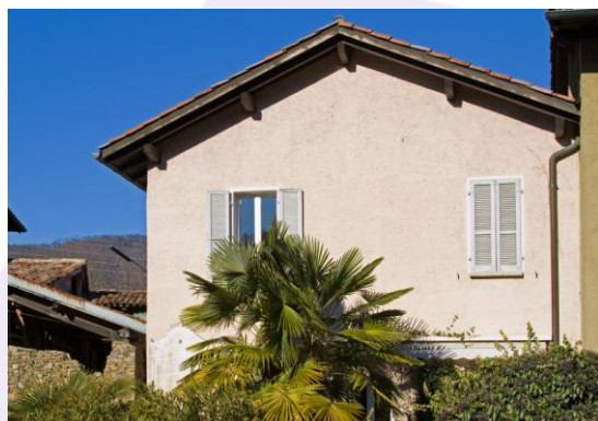
Vista esterna giardino
