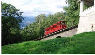
Seilbahn auf den Monte Brè
